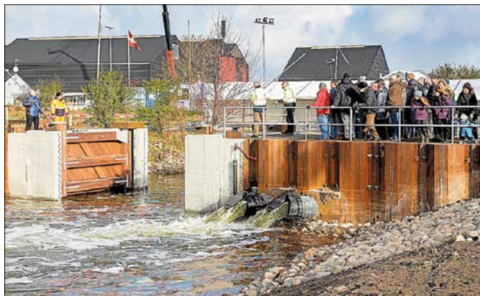
Den ny højvandsluse, der skal sikre Frederiksværk, blev officielt indviet.
